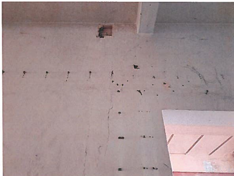
Slika 26: Na več mestih prisotne razpoke na zidovju
