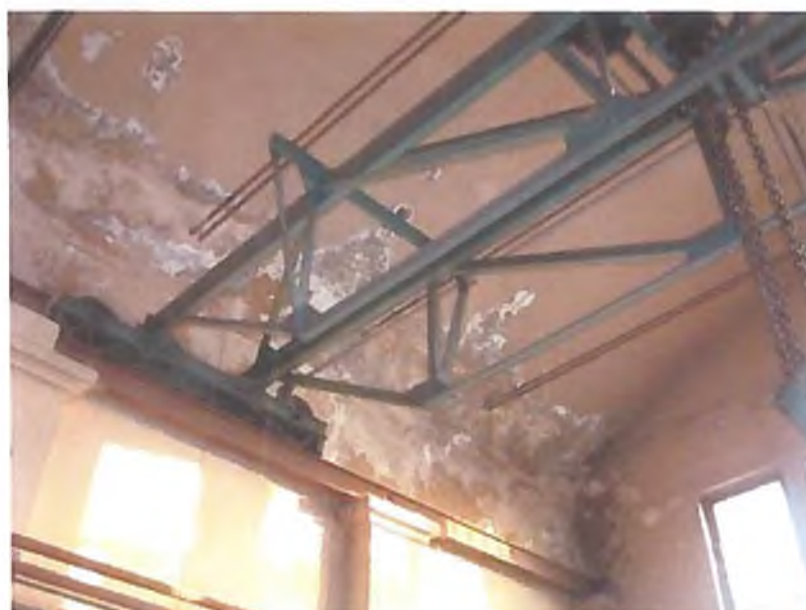
Slika 26: Obsežne poškodbe armiranobetonske strešne kupole.
