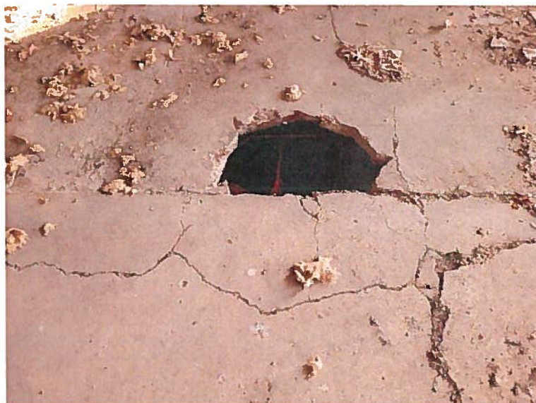
Slika 17: Etažna konstrukcija nad pritičjem v AB izvedbi
