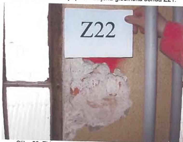
Slika 53: Zidna sonda Z22, gradiva ter sestava kot Z1.
