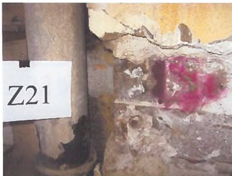
Slika 51: Zidna sonda Z21, v betonski sloj so vgrajeni močnejši kovinski profili, ki so medsebojno povezani s ploščatimi kovinskimi trakovi. Ti kovinski profili so vgrajeni, ker na preiskani steber nalega težka industrijska oprema prikazana na sliki 21. Podobne ojačitve betonskih prerezov so vidne tudi na slikah 21 in 22.
