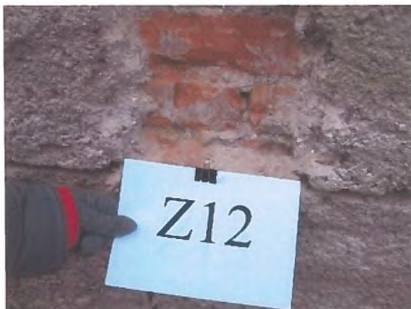
Slika 42: Zidna sonda Z12, gradiva ter sestava kot Z1.
