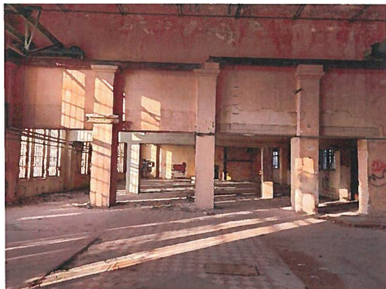
Slika 23: Vertikalna konstrukcija v 1. nadstropju, ki podpira strešno kupolo
