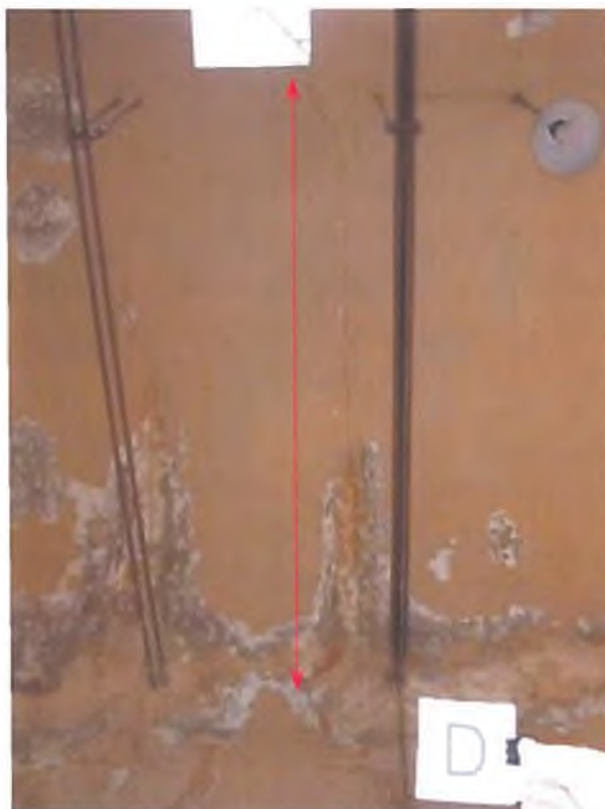
Slika 28: Na nekaterih mestih potekajo razpoke od ležišča kupole pa vse do njenega temena oziroma do temenskih svetlobnikov..
