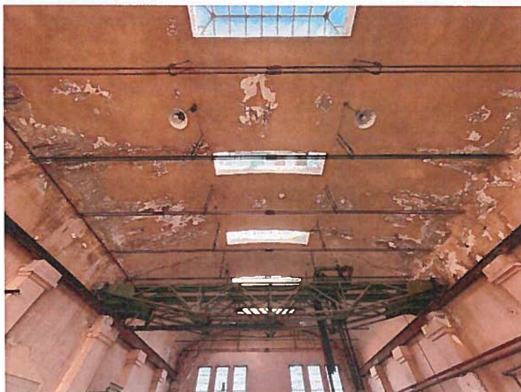
Slika 13: Strešna konstrukcija nad večjim prostorom izvedena kot banjasta kupola
