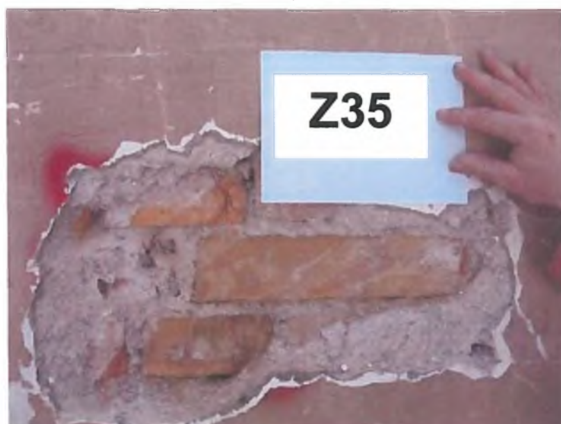
Slika 66: Zidna sonda Z35, gradiva ter sestava kot Z1.
