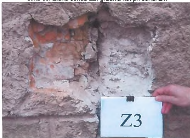
Slika 31: Zidna sonda Z3, stik osnovne zgradbe in prizidka, gradiva kot pri sondi Z1 (prizidek) in nearmirani betonski sloj (osnovna zgradba).
