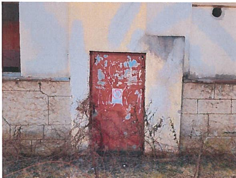
Slika 11: V območju ojačitvenega vertikalnega slopa izvedena odprtina za vrata
