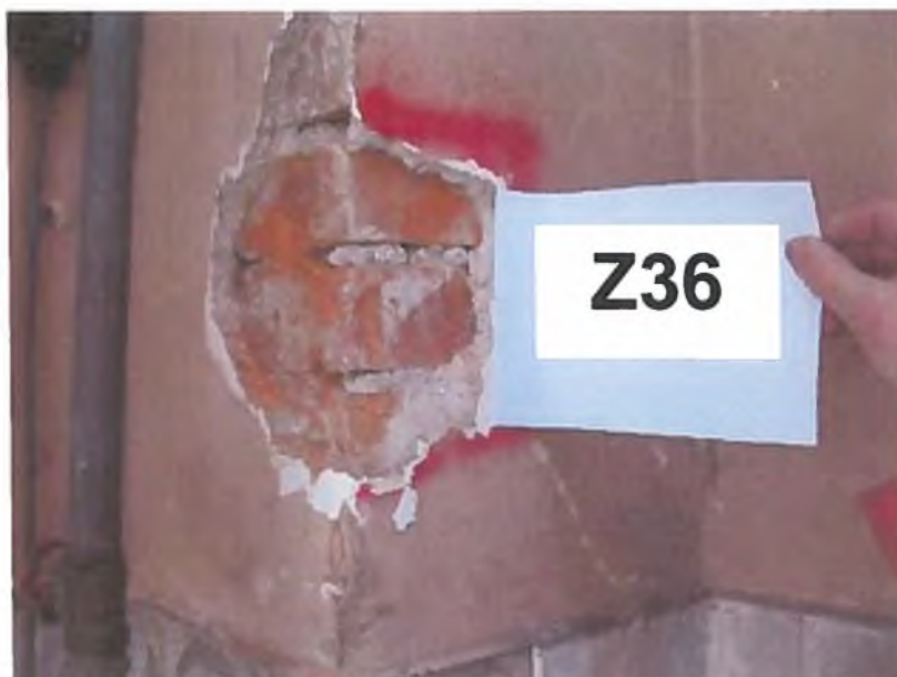
Slika 67: Zidna sonda Z36, gradiva ter sestava kot Z1.
