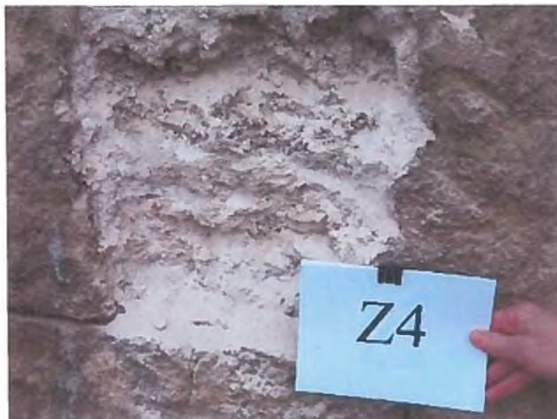
Slika 32: Zidna sonda Z4, nearmirani beton slabše kvalitete, precej porozna struktura.
