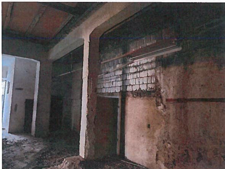
Slika 28: Razne naknadne pozidave in prezidave v pritličju
