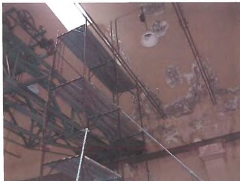
Slika 73: Pri preiskavah armiranobetonske kupole smo si pomagali z visokimi gradbenimi odri.
