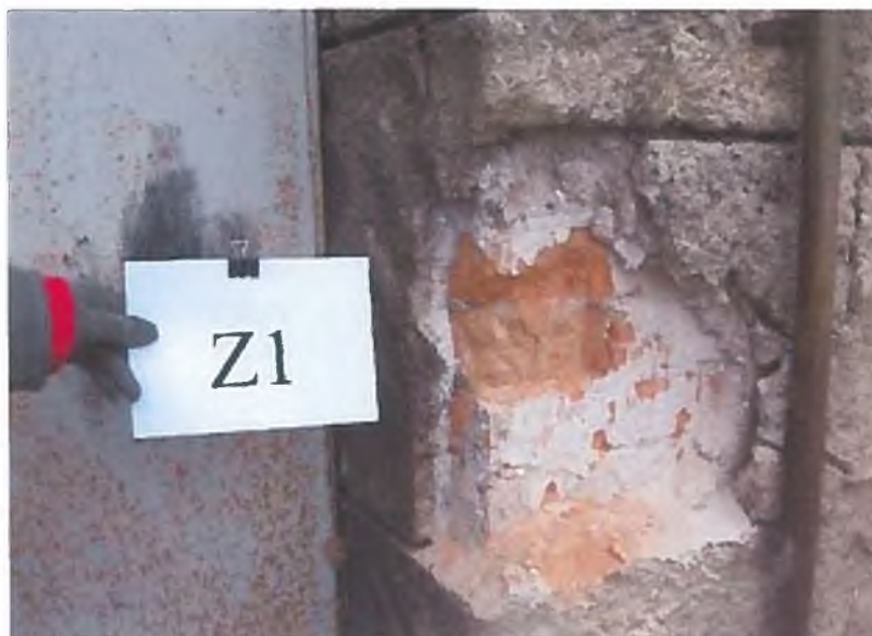
Slika 29: Zidna sonda Z1, opečno gradivo (NF zidak), srednje dobra apneno – cementna malta, pravilni zidarski spoji, finalni apneno – cementni omet.
