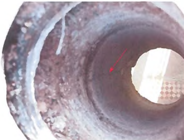
Slika 78: Poblížja predstavitev luknje izvrtanega valja z oznako V2. Jasno je vidna razpoka, ki sega preko celotne debeline armiranobetonske kupole. Nad armiranobetonsko konstrukcijo je izdelan sloj lahkega betona ( t.i. Leca beton), sledijo sloji kritine.
