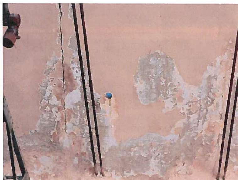
Slika 15: Izrazita razpoka, odpadanje ometa kupole, površinska degradacija betona, sledi zamakanja in premakanja
