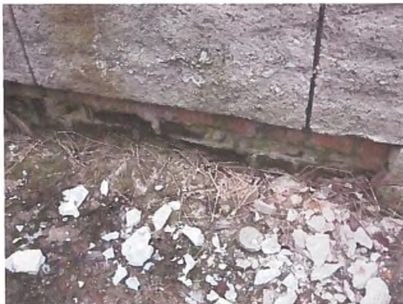
Slika 15: V Z prizidku, segajo opečno gradivo obodnih zidov vse do urejenega okoliškega terena (problematika navlaževanja in propadanja).
