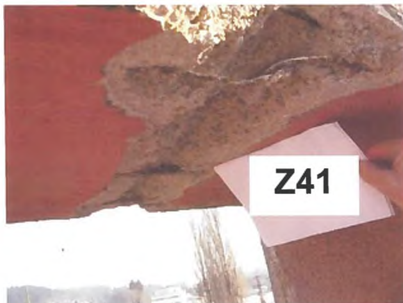
Slika 72: Zidna sonda Z41, armiranobetonske preklade kot zaključek zunanjega parapetnega zidu, uporabljen je beton slabše kvalitete.
