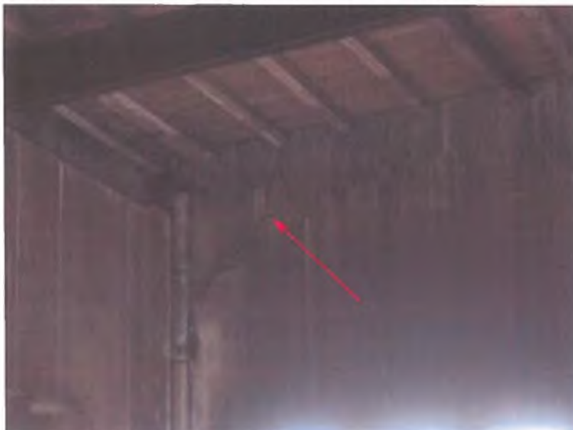
Slika 23: Poškodba – široka razpoka, ki je jasno prikazana v parapetnem zidu na sliki 13 je tu predstavljena tudi na notranji strani omenjenega parapetnega zidu.
