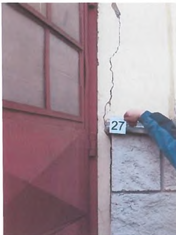
Slika 19: Nekatere vidnejše poškodbe na nosilnem zidovju zgradbe.
