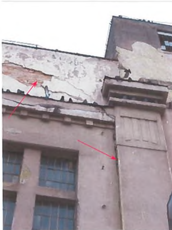
Slika 17: Na stiku osnovne zgradbe (desno) ter prizidka (levo) so zaradi nepravilnega dilatiranja konstrukcij nastale obsežne poškodbe (J fasada, vrh zgradbe).
