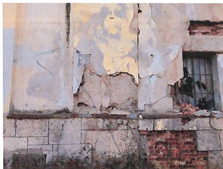
Slika 6: Odpadanje fasadnega ometa, degradacija opečnatih zidovja in betonskega vertikalnega slopa
