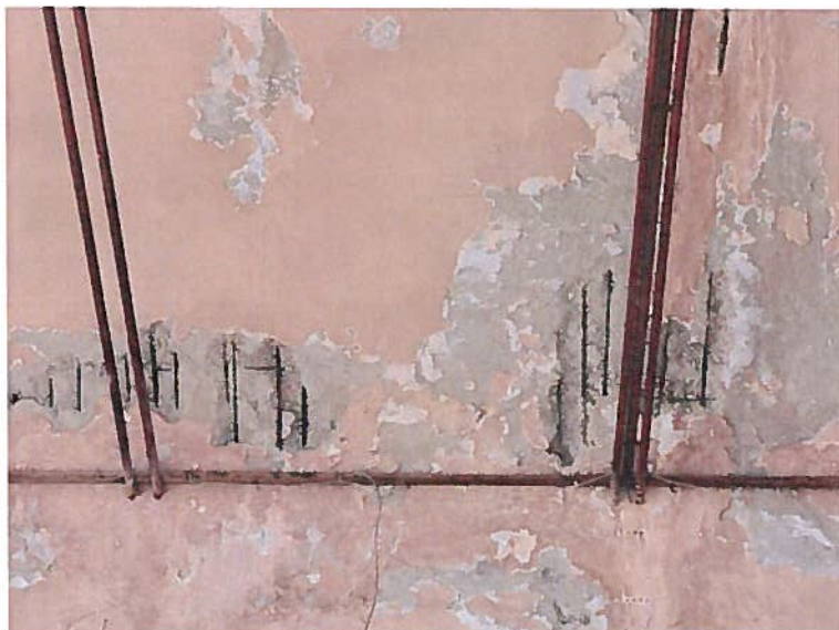
Slika 14: Odpadanje krovne sloja betona kupole, vidna armatura, ki je podvržena koroziji
