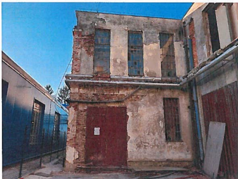
Slika 7: Na več območjih odpadanje fasadnega ometa, degradacija opečnatega zidovja
