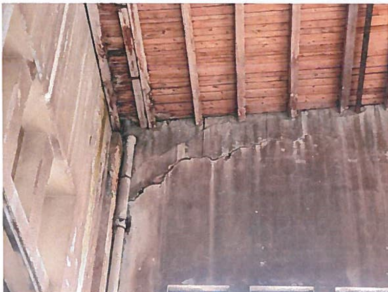
Slika 25: Izrazita razpoka v območju zaključka obodnega zidu
