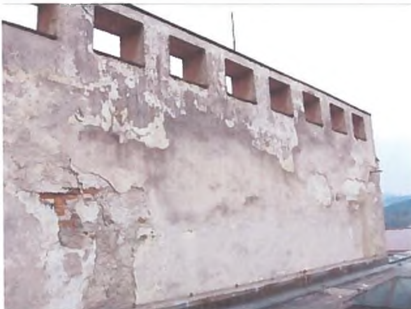
Slika 8: Precej dotrajani elementi konstrukcij - zunanji zidovi na nivoju strešnih konstrukcij zgradbe.
