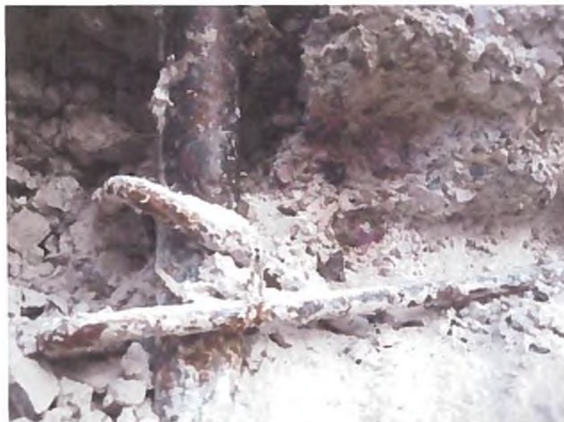
Slika 39: Beton vgrajen v (armirano) betonske konstrukcije na zunanjih zidovih vgrajeni mehki armaturi ne nudi zadostne zaščite – izjemno slaba, praktično nična reakcija ob fenolftaleinskem testu.
