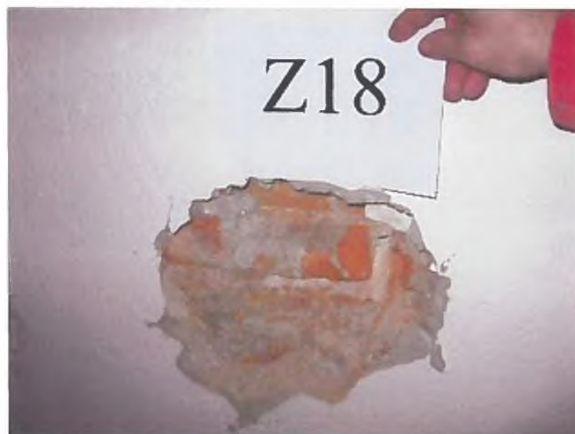
Slika 48: Zidna sonda Z18, gradiva ter sestava kot Z1.
