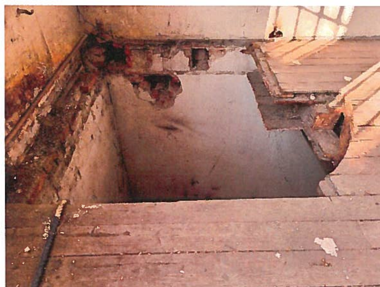
Slika 18: Etažna konstrukcija nad pritičjem v leseni izvedbi
