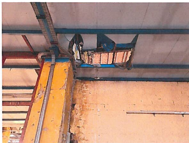
Slika 20: Stropna konstrukcija nad 1. nadstropjem v jekleni izvedbi
