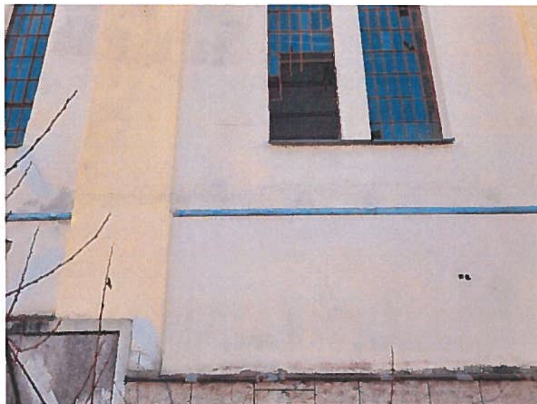
Slika 8: Več horizontalnih razpok na fasadnih površinah objekta
