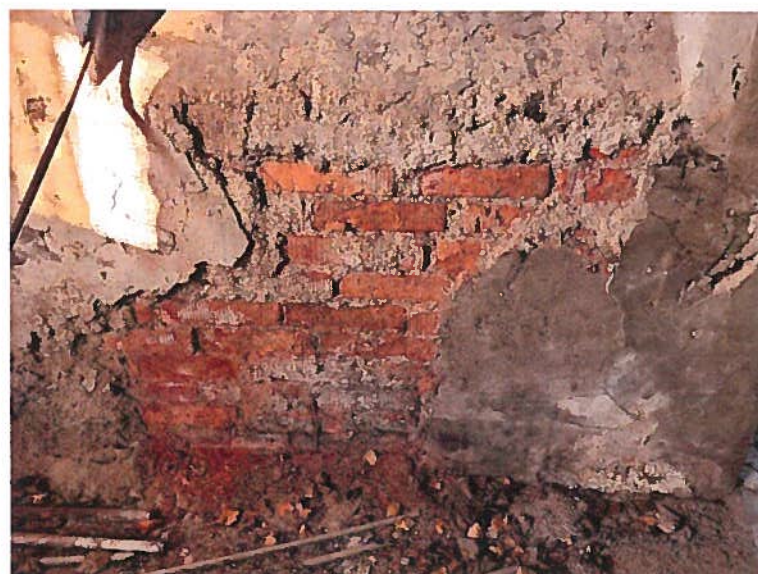
Slika 30: Odpadanje ometa na notranjem zidu v pritličju
