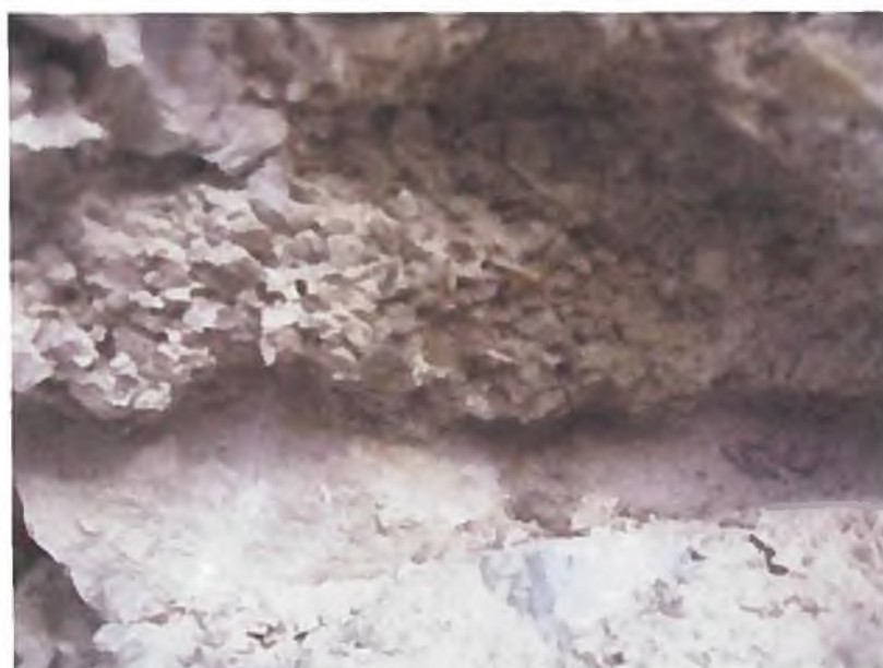
Slika 40: Komentar kot na prejšnji fotografiji, vidna je tudi izjemno porozna struktura vgrajenih beotnov.
