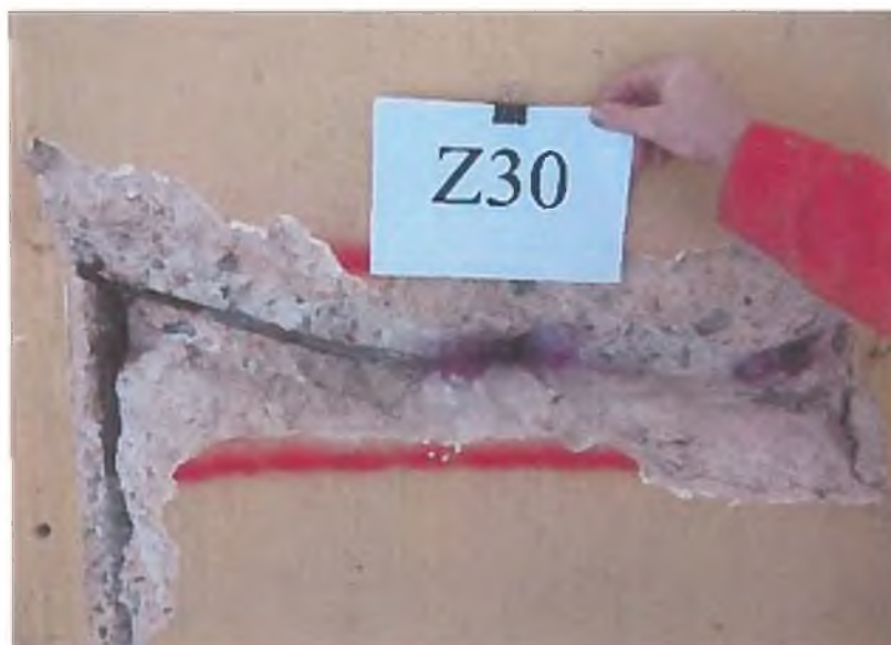
Slika 61: Zidna sonda Z30, gradiva ter sestava kot Z5.
