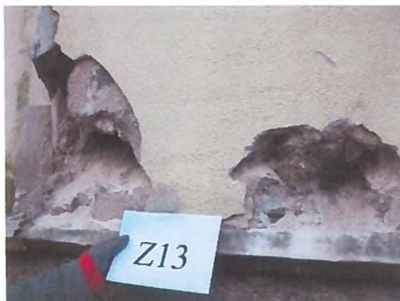
Slika 43: Zidna sonda Z13, gradiva ter sestava kot Z4.
