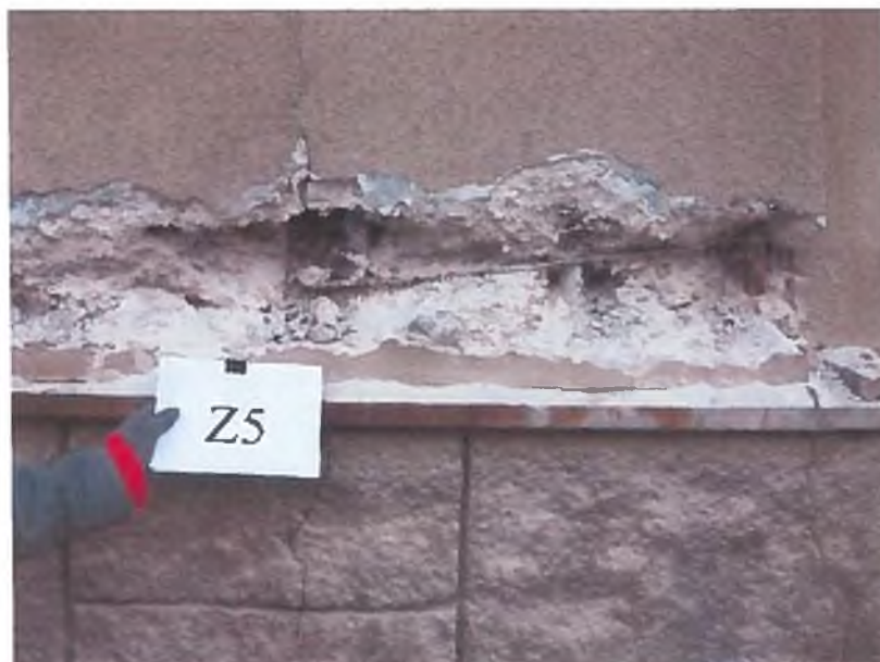
Slika 33: Zidna sonda Z5, mehka armatura je vgrajena le v polovici vertikalnega betonskega slopa, beton slabše kvalitete, precej porozna struktura.
