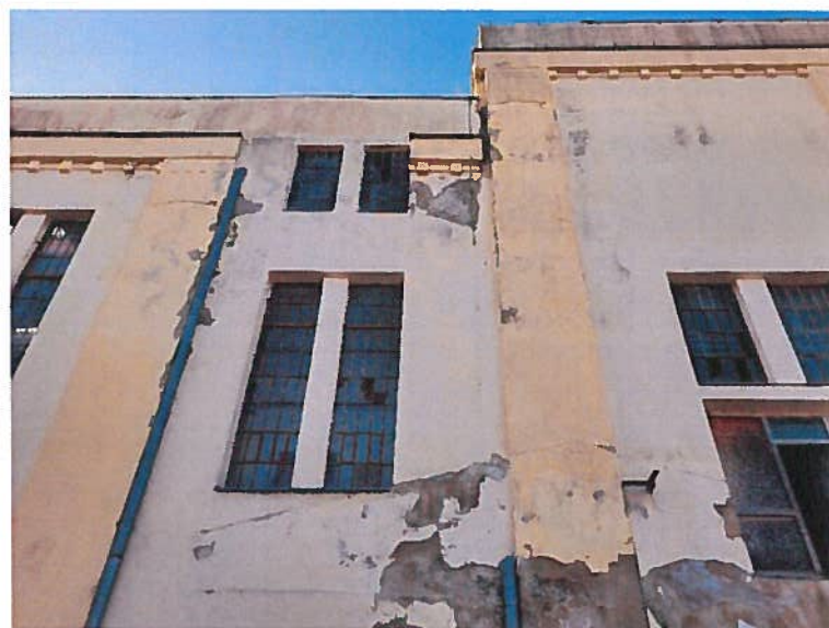
Slika 9: Na več mestih odpada fasadni omet, na več mestih prisotne razpoke
