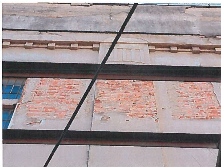
Slika 5: Odpadanje fasadnega ometa, degradacija opečnatih zidovja
