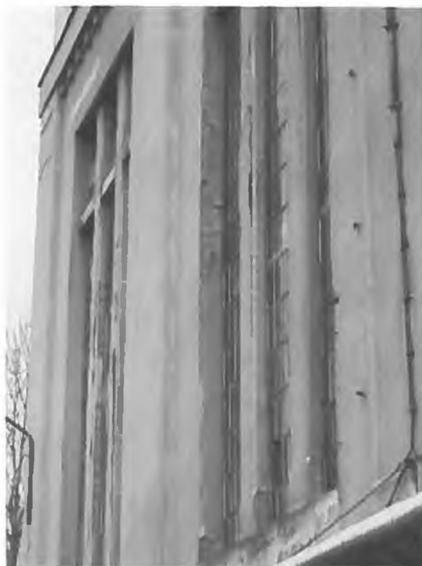
Slika 13: V Z prizidku, ki je bil k osnovni zgradbi prizidan v štiridesetih letih preteklega stoletja so prisotni vitki opečni medokenski slopi.
