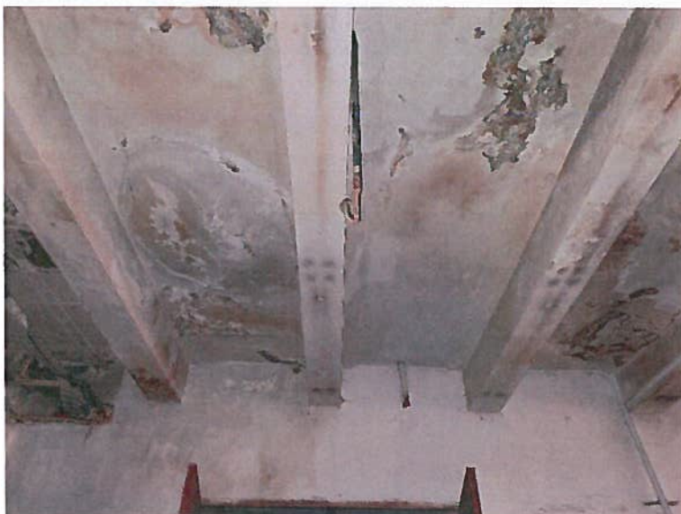
Slika 16: Etažna konstrukcija nad pritičjem, sledi premakanja, odpadanje zaključnih slojev
