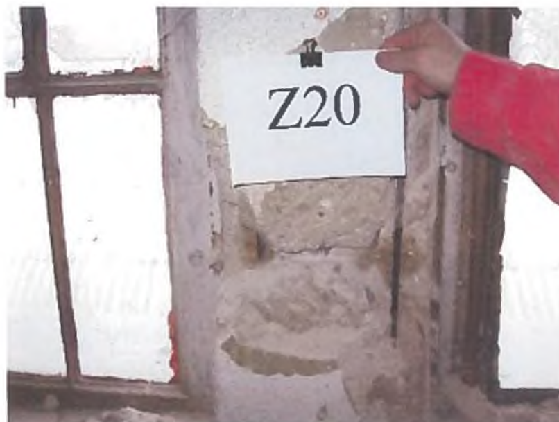
Slika 50: Zidna sonda Z20, armirani beton slabše kvalitete.
