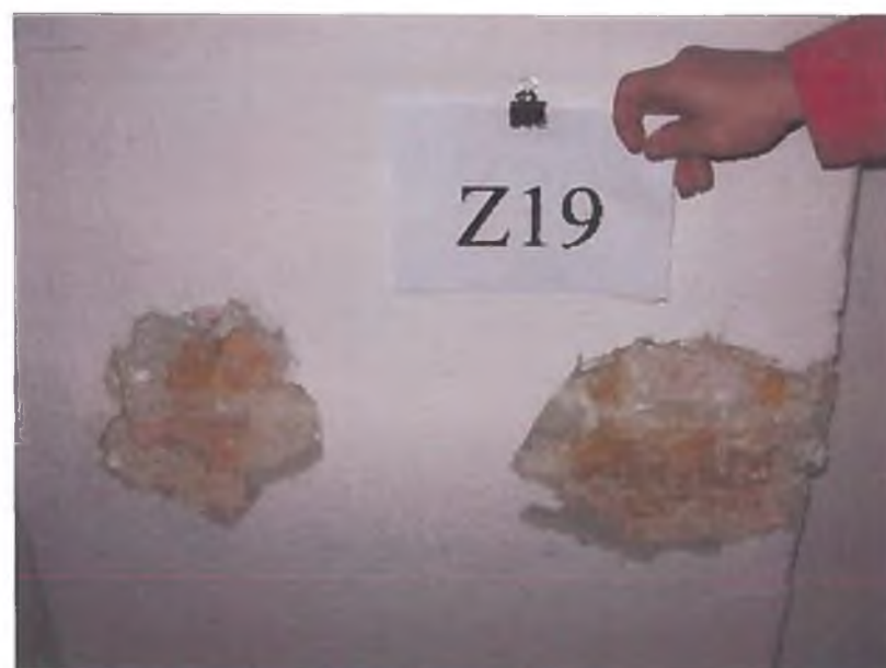
Slika 49: Zidna sonda Z19, gradiva ter sestava kot Z1.
