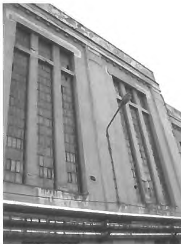
Slika 14: Medokenski slopi osnovne zgradb pa so izdelani v armiranem betonu.
