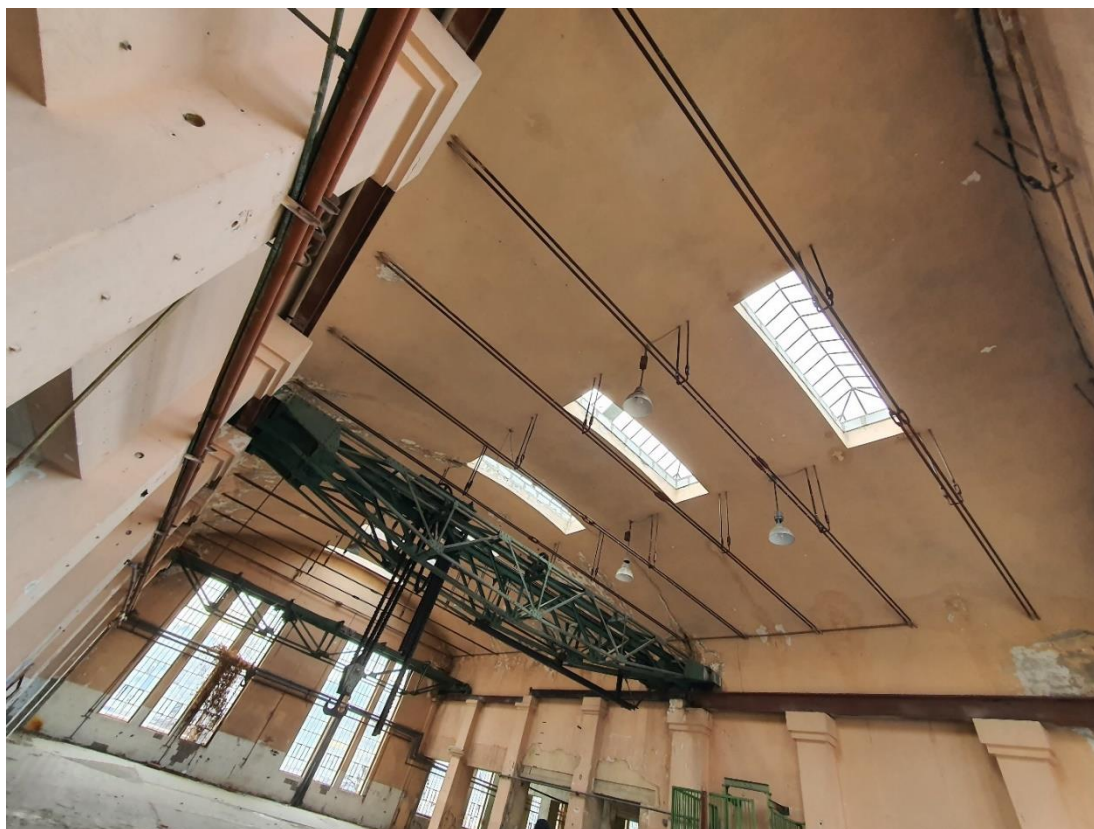
Stara elektrarna – kupola, svetlobniki, proga in obe mostni dvigali v dvorani (arhiv S7 d.o.o.)
