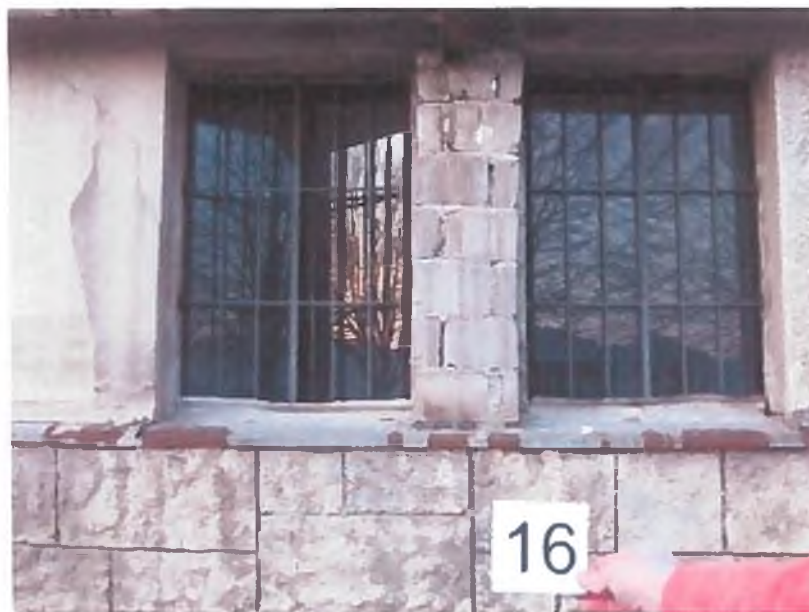
Slika 16: Strokovno neustrezne prezidave v preteklosti.
