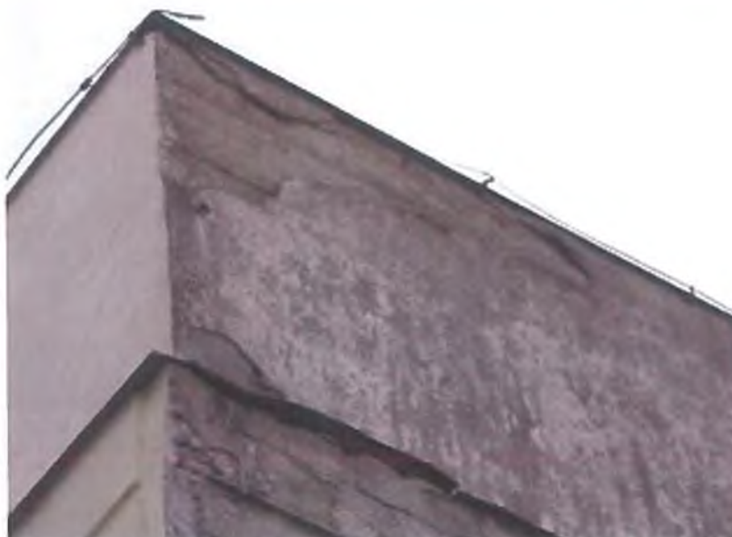
Slika 12: Nekateri parapetni zidovi – zunanji vertikalni zaključki zidov so izdelani iz masivnega (ne?) armiranega betona .
