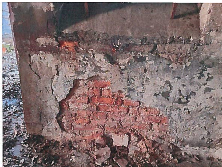
Slika 29: Odpadanje ometa na notranjem zidu v pritličju
