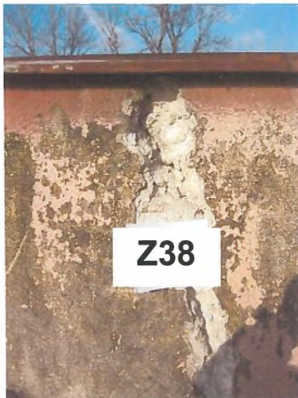
Slika 69: Zidna sonda Z38, nearmiran betonski parapet, beton slabše kvalitete, prisotna široka vertikalna razpoka.
