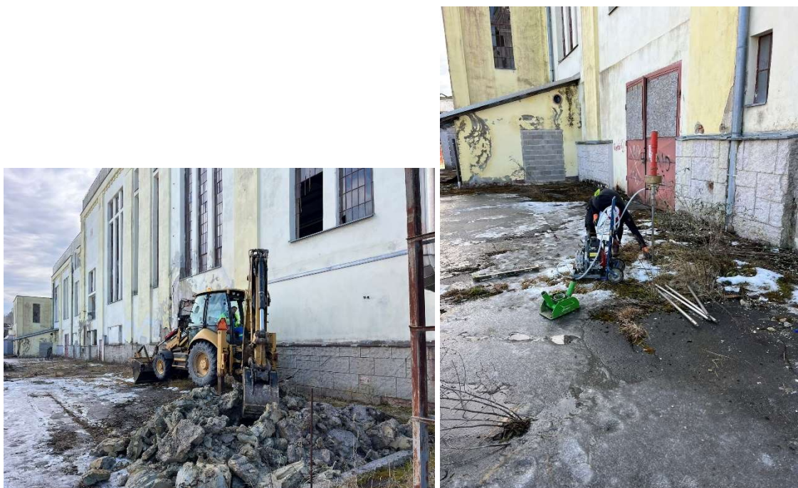
Slika 2: Izvedba sondažnih izkopov ter dinamične penetracije
