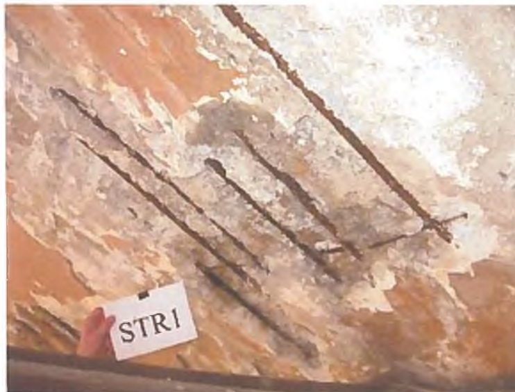
Slika 74: Stropna sonda STR1, kvaliteta vgrajenih betonov se glede na mesto vgradnje precej spreminja. Zaradi dolgotrajnega zamakanja so nastale obsežne poškodbe krovnih slojev betona, prisotna je tudi korozija vgrajene mehke armature.
