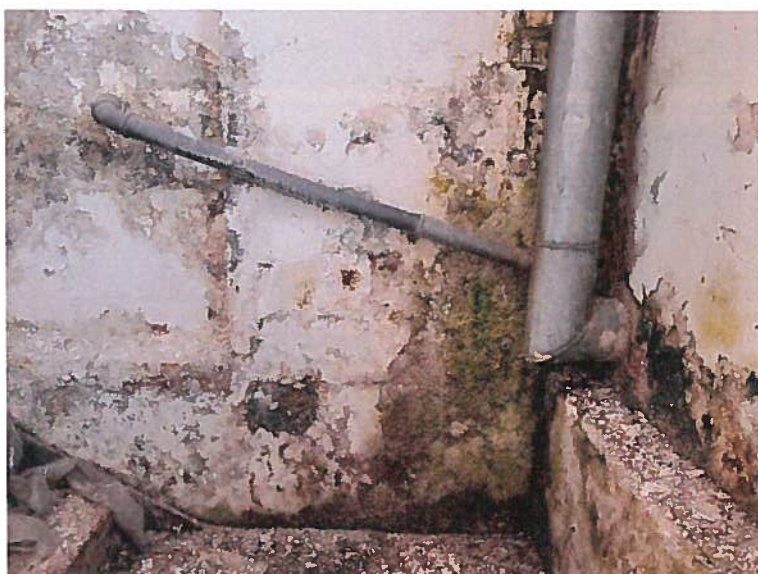
Slika 27: Sledi izrazitega zamakanja zidovja v območju stopnišča
