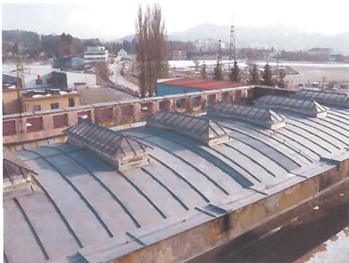
Slika 6: Nad V delom zgradbe predstavlja nosilno konstrukcijo strehe armiranobetonska kupola s šestimi svetlobnimi jaški.
